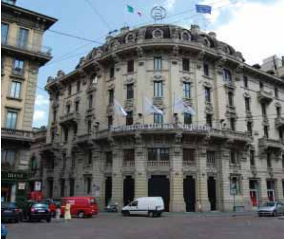
La facciata liberty dell'Hotel Diana in viale Piave
